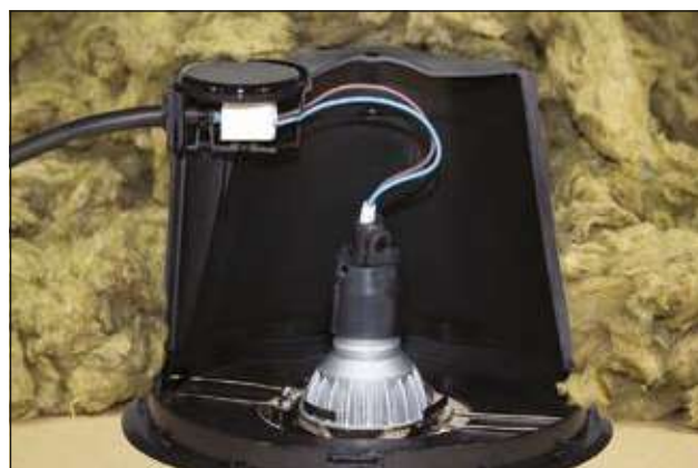
Vue intérieure, en coupe, d'un SpotClip-Box, en application.
