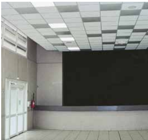
Les Thermocassettes CTS sont souvent utilisées dans les locaux publics. Il est possible de les monter dans des plafonds inclinés.
