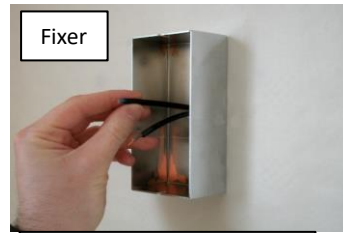
Insérer les gaines fournies sur les fils
