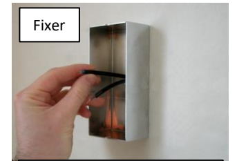
Insérer les gaines fournies sur les fils
